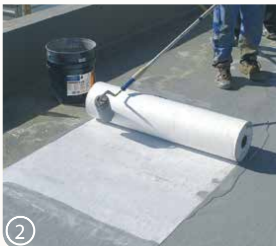
2 Il tessuto non tessuto assorbente è dispiegato sulla resina ancora liquida
