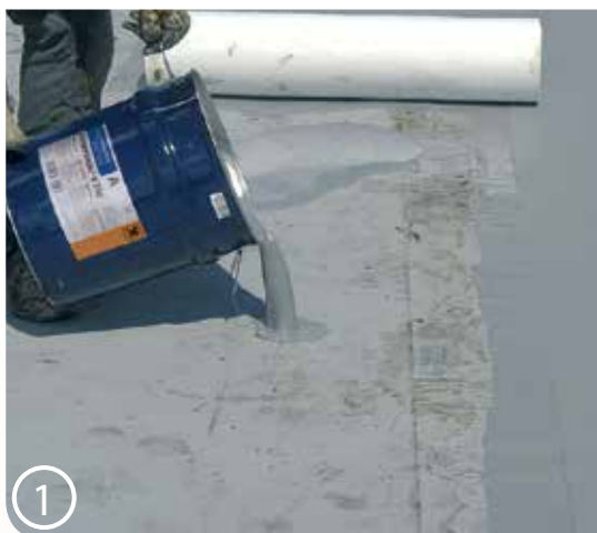
1 La prima mano di resina KEMPEROL® è applicata sul supporto
